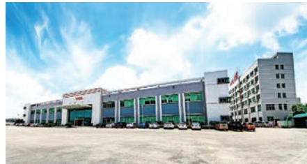
Jiujiang Base (2 εκ. σετ κλιματιστικών)
